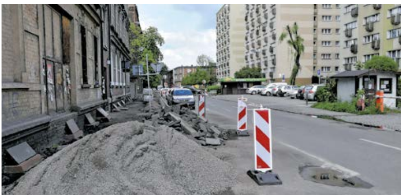
Rozpoczął się remont ulicy Paryskiej. Wymieniona zostanie kanalizacja w rejonie skrzyżowania ulic Jasnej i Wojska Polskiego oraz nawierzchnia całej ulicy.
