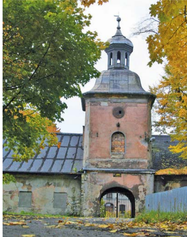
Pałac - widok skrzydła A - brama wjazdowa tuż przed rozpoczęciem inwestycji
