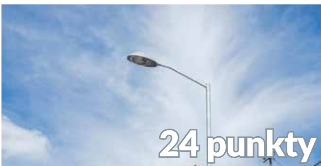
USPRAWNIENIA DROGOWE WYMIANA SŁUPÓW OŚWIETLENIOWYCH
