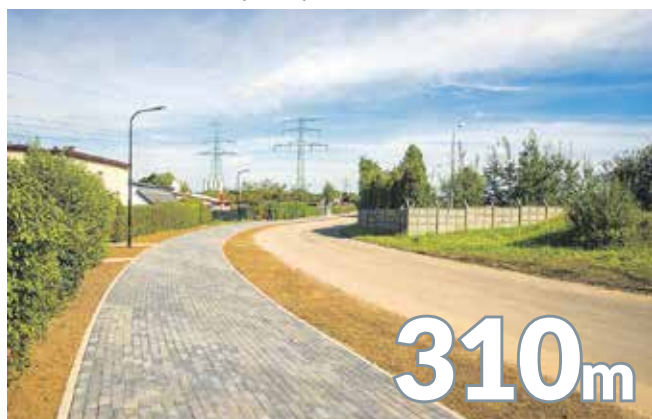
CIĄG PIESZO-ROWEROWY PRZY UL. TOWAROWEJ Z OŚWIETLENIEM TOWAROWA (BO)
