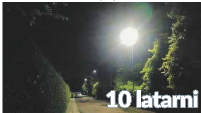
USPRAWNIENIA DROGOWE OŚWIETLENIE NA ULICACH OKRZEI I TURYSTYCZNEJ (BO)
