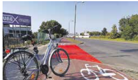
ŚCIEŻKA ROWEROWA przy ul. Obwodowej (na Pszczelnik)
